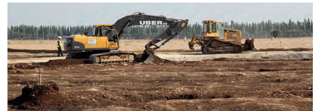
TRAVAUX DE DÉCAISSAGE DE SOL POLLUÉ DANS LA PLAINE DE LA CRAU SUITE À UNE RUPTURE DE PIPELINE EN 2009
